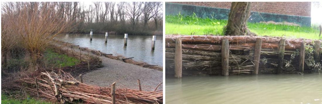
om afkalving te voorkomen worden wilgebundels op verschillende wijzen ingezet
